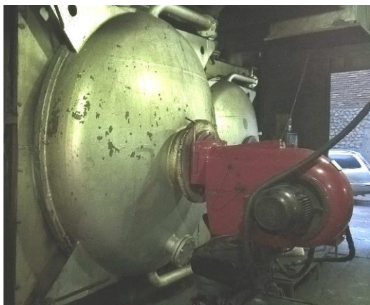
Слика 4.4. Топловодни котао котла
