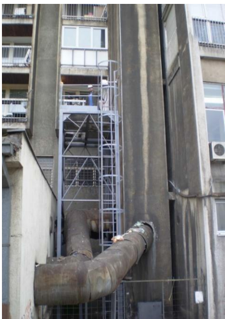
Слика 4.6. Улаз димљача котлова у бетонски емитер
