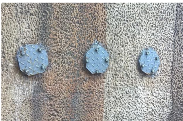
Слика 4.8. Мерна места топловодног котла
